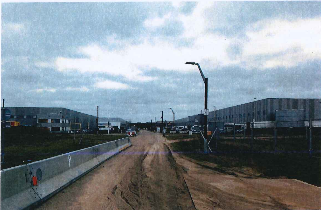
Afbeelding 5.1: situatie bedrijfsgebouwen appellanten nabij toekomstige locatie windturbine 3, links Venlo Logistics, daarachter Solar Logistics en rechts Frasers.
